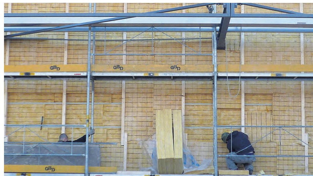
Bei der SFS-Hallensanierung wurden unter anderem 1600 Quadratmeter Wand erneuert.
